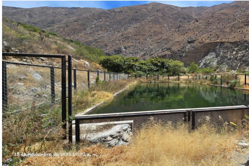
FIGURA N°02: RESERVORIO IRURUPA CON CAPACIDAD DE 1500 M3 PARA RIEGO Y CONSUMO DE AGUA
